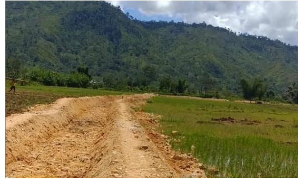
Photo 2. Exemple type de mise en œuvre de canal d'irrigation sur remblais impactant des rizières
